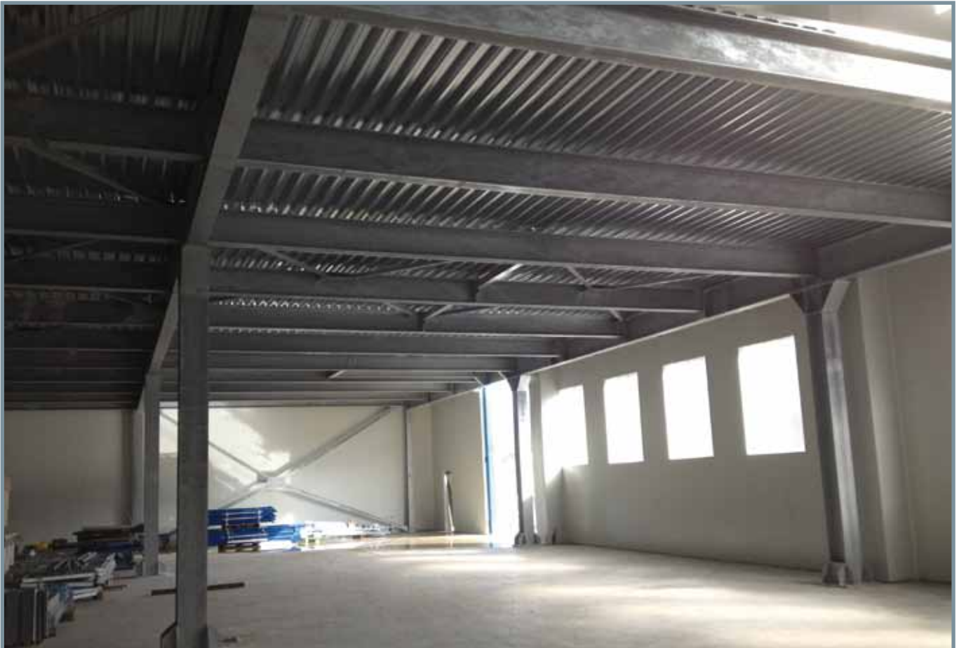
Vista soppalco zincato a caldo
