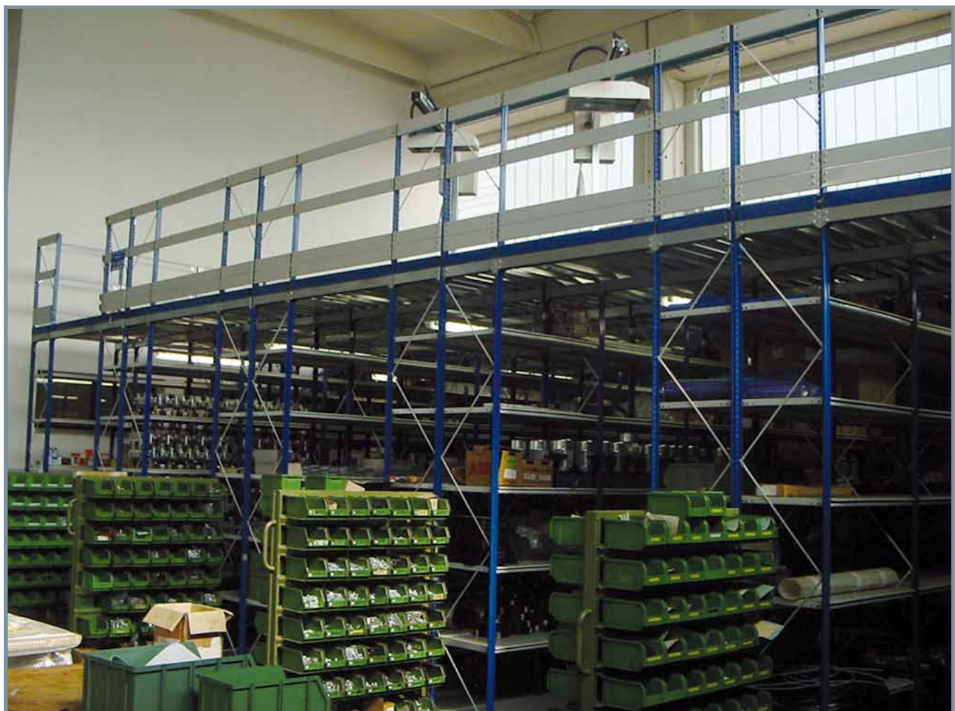
Vista impianto RI soppalcato
