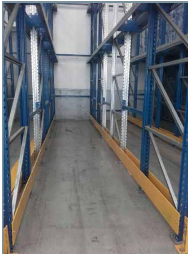
Particolare di un canale Drive-In
