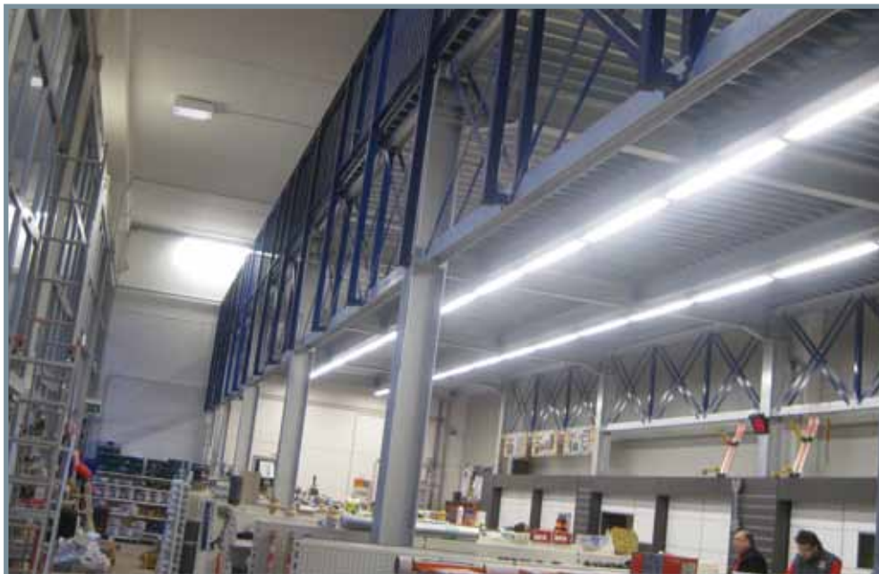
Vista impianto con montacarichi e scala di collegamento
