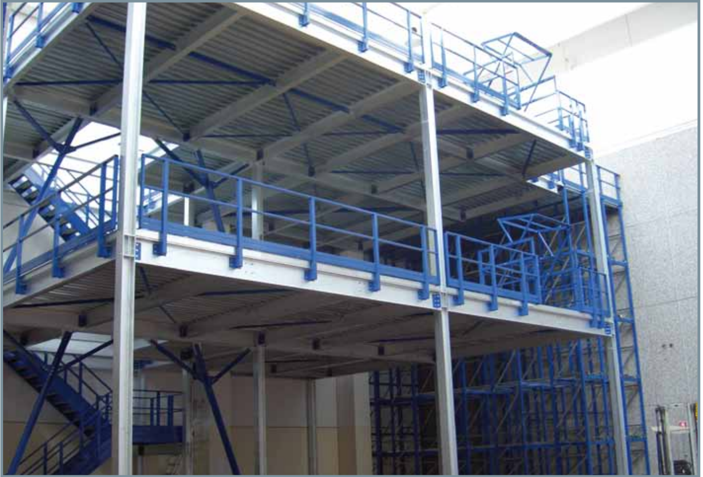
Vista soppalco a più livelli con scala e montacarichi
